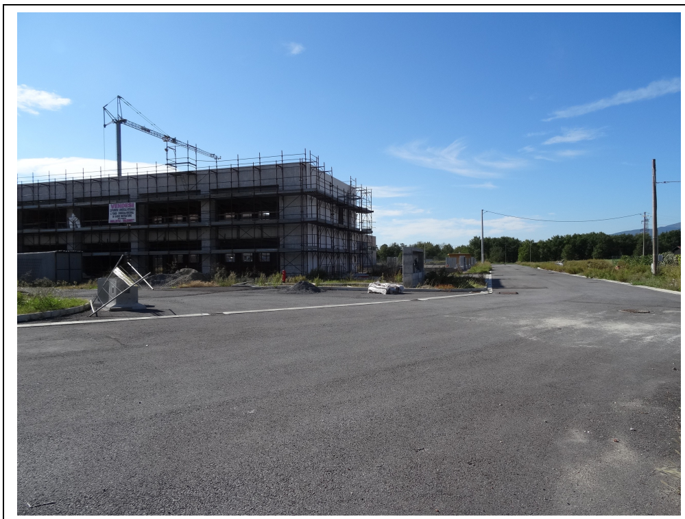
Foto degli edifici in corso di esecuzione
