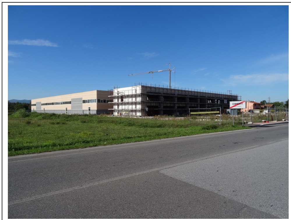
Foto degli edifici in corso di esecuzione
