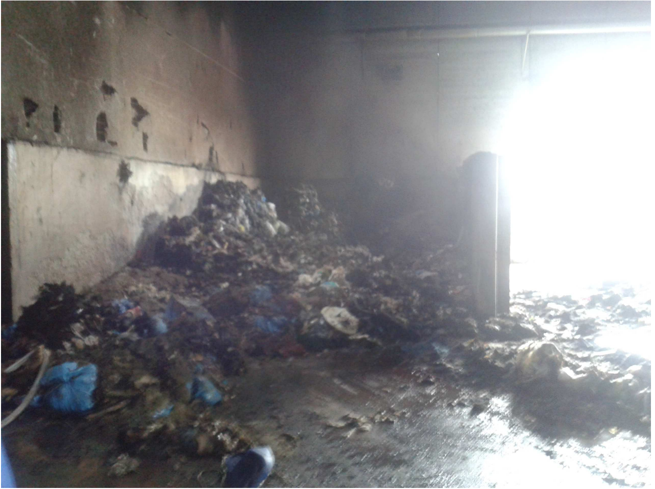
- Foto 3 – 10.09.2016, baia con rifiuti CER 191211 dove è scaturito l'incendio
