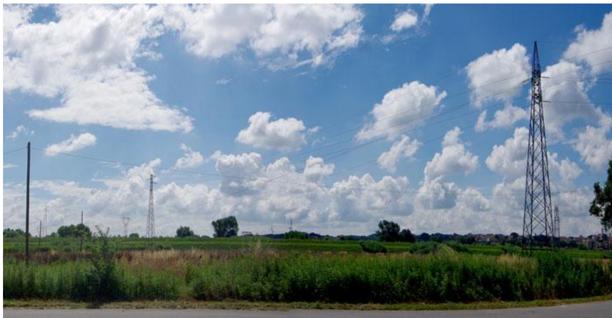
Fotografia illustrante il traliccio presente in prossimità dell'area oggetto della Variante
