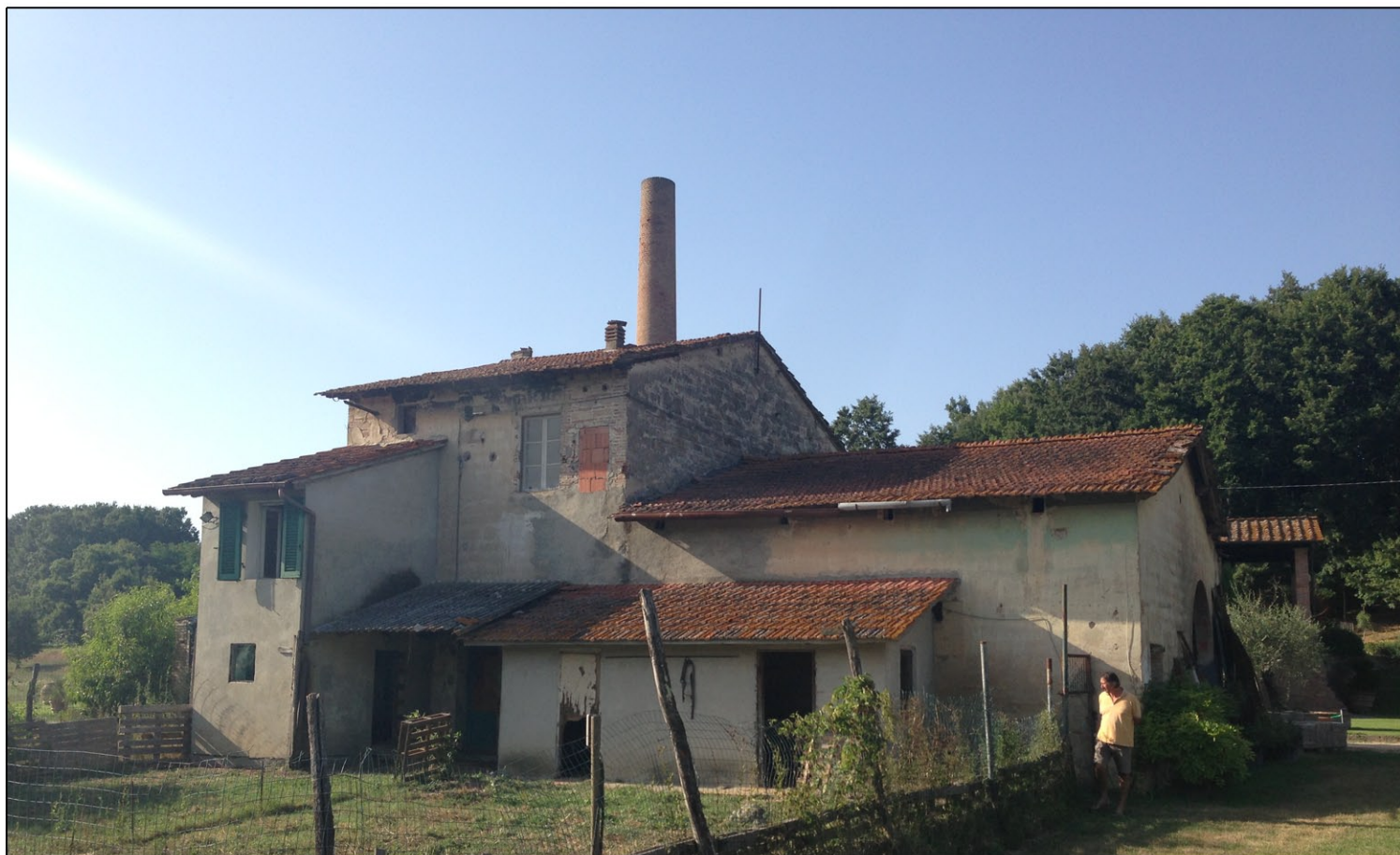
Foto n. 5 - Vista del retro del fabbricato
