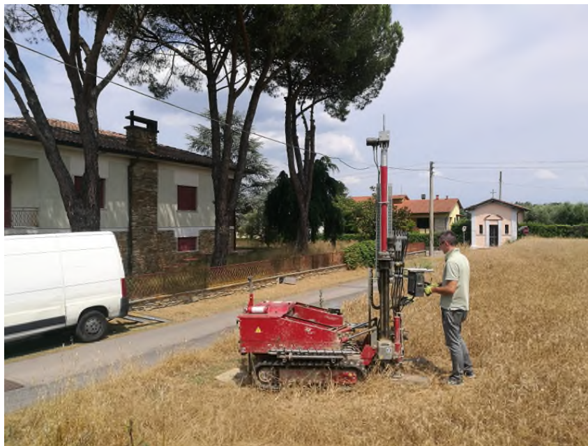
Prova penetrometrica dinamica
