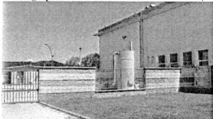
Stazione sollevamento di Via del Trebbio
