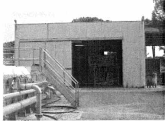
locale flottatore, centrifuga
